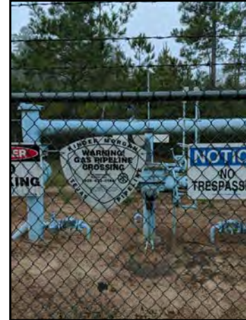
20 : PIPELINE ON SITE
